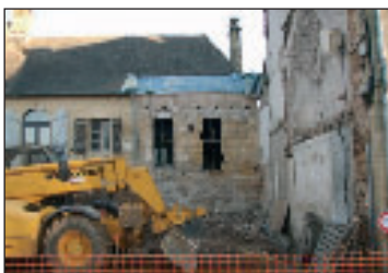
Travaux du Point I
