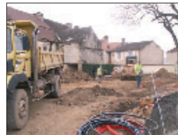
Les travaux de la place du Marché
