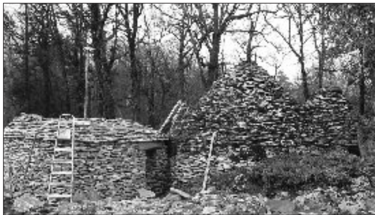
Une borie en cours de restauration
