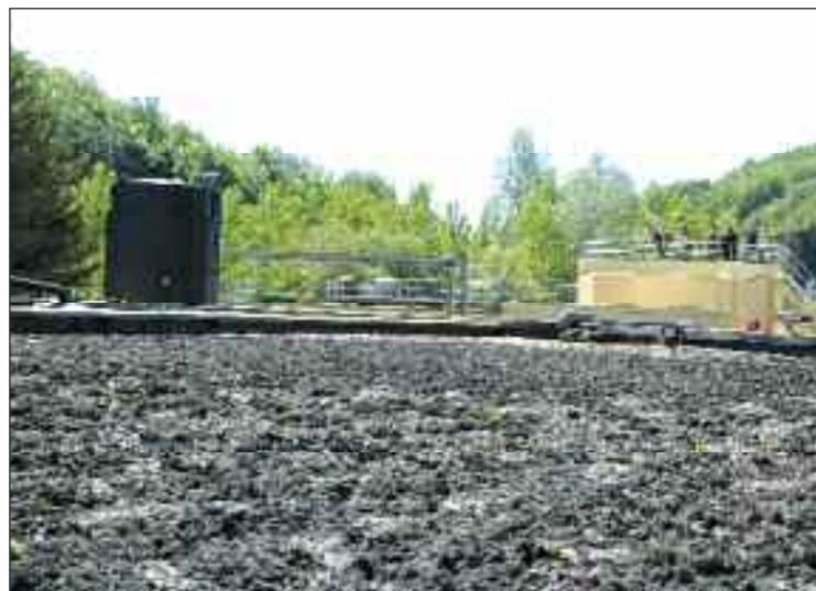
Les effluents dans le bassin anoxie et préaération. Dans la zone anoxie, les nitrates sont transformés en azote gazeux (rejeté dans l'atmosphère) et en oxygène (nécessaire à la vie des bactéries).
