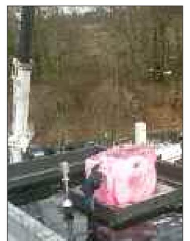
Le matériel a été hissé à l'aide d'une grue et a été introduit dans le bâtiment en passant par une trappe large de 1,50 m située sur le toit (Photo DR)
