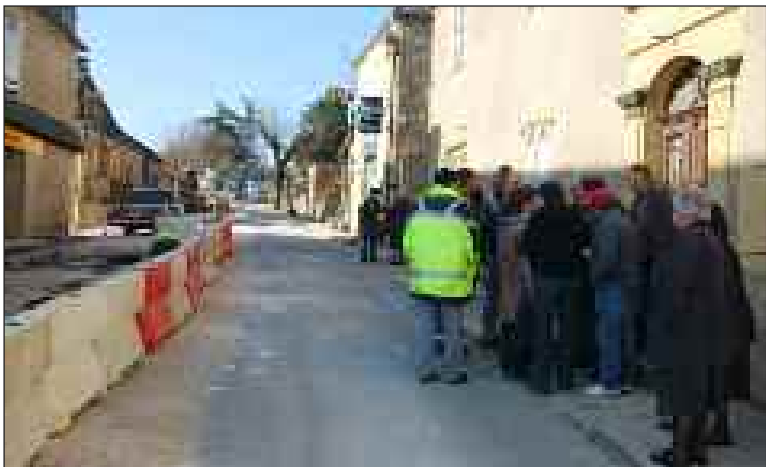
Les habitants du haut du bourg visitent le chantier avec les membres de la commission travaux, le maire Michel Lajugie, l'architecte M. Chaland et les différents acteurs prenant part aux travaux
