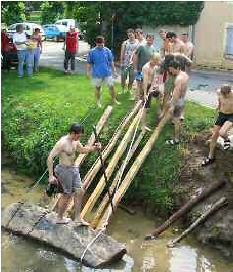
Des travaux herculéens
