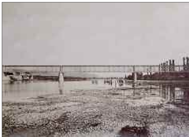
Le pont du Garrit à sa création en 1895
