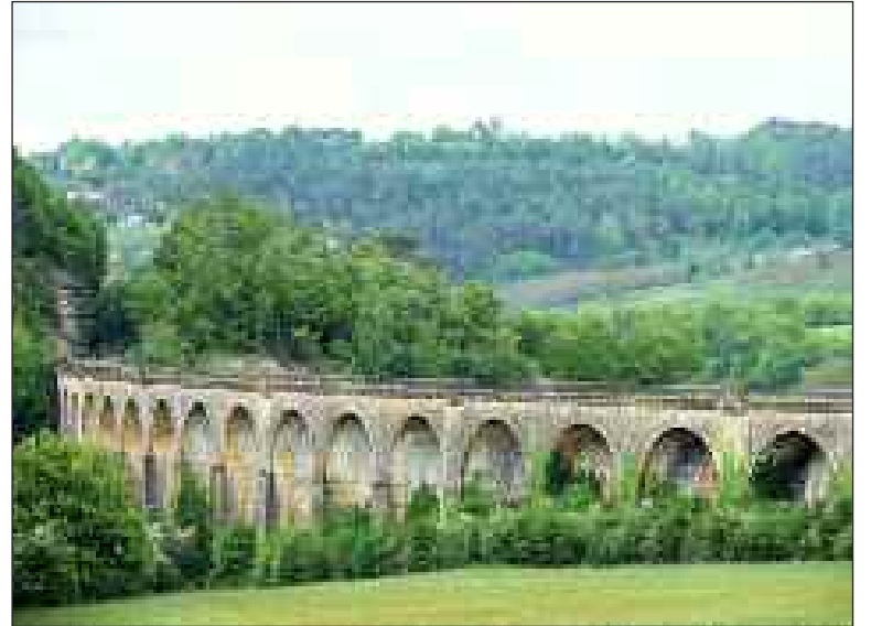
Le viaduc en courbe de Larzac. D'architecture rarissime, cet ouvrage de 301 m est le plus long du département
