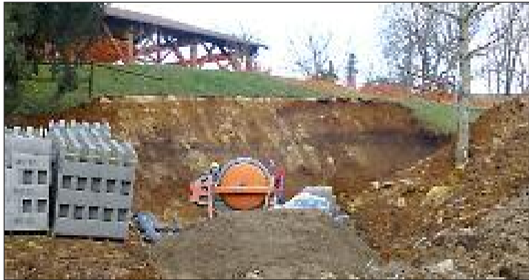
Le chantier en dessous de la halle du pèlerin. A droite, au premier plan, le ginkgo à préserver
