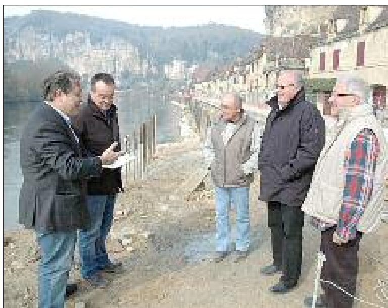
Chaque vendredi, une réunion de chantier permet de faire le point. Le 1 er mars, Jérôme Peyrat s'entretenait avec Jean-Luc Perreu et les élus locaux André Georgy, Roger Mondy et Bernard Pichenot (Photos GB)
