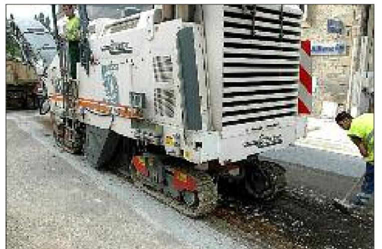
A l'aide d'une fraise, la raboteuse détruit le bitume
