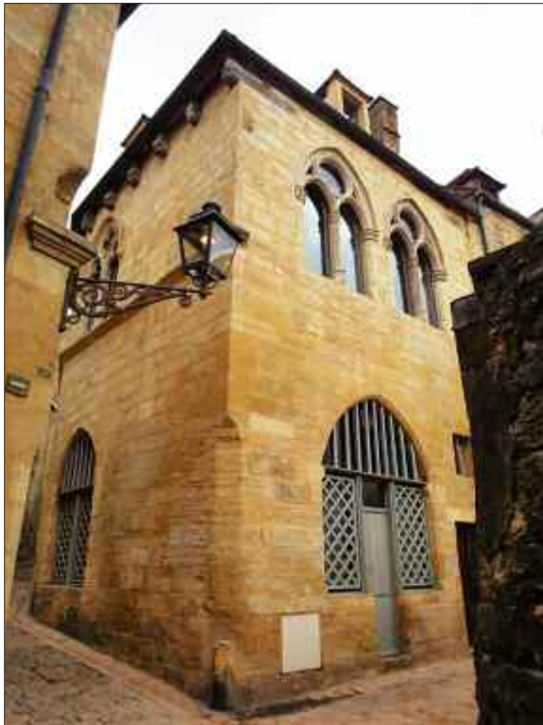
Sarlat et la loi Malraux, le n° 8 de la rue du Siège après travaux
