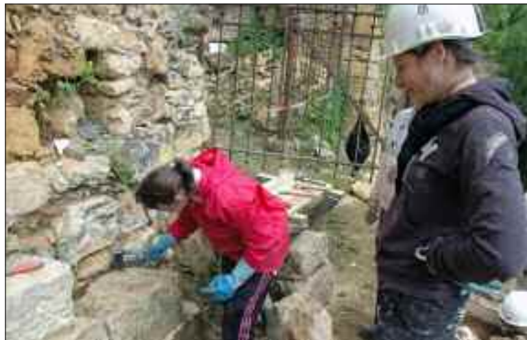
Mélanie regarde Sandrine travailler les pierres du mur de la forteresse (Photo GB)
