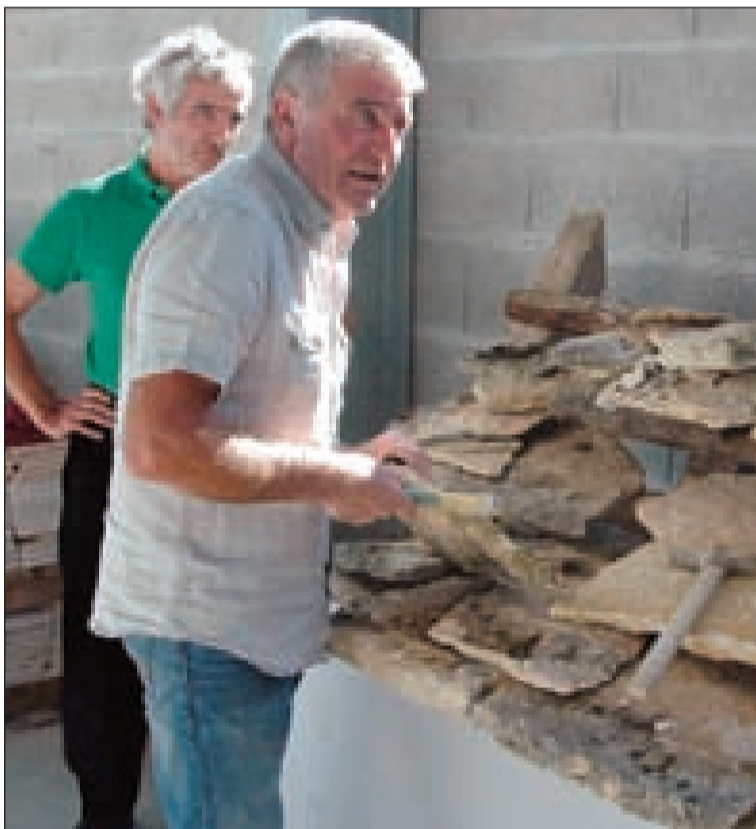
Sous le regard de Claude Crouzel, Francis de Carlos a fait une démonstration de pose de lauzes
