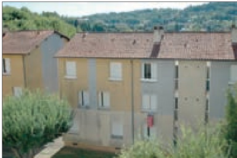
Dans le quartier du Pouget à Sarlat
